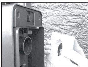
Filterraumdeckel öffnen und vollen Staubbeutel herausnehmen. Neuen Staubbeutel mit der Haltescheibe auf den Stutzen im Behälter aufsetzen und bis zum Anschlag nach hinten schieben.
